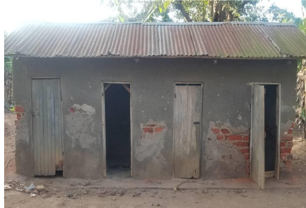
Boys toilet at Bigada P/S in Kakuuto- Kyotera
